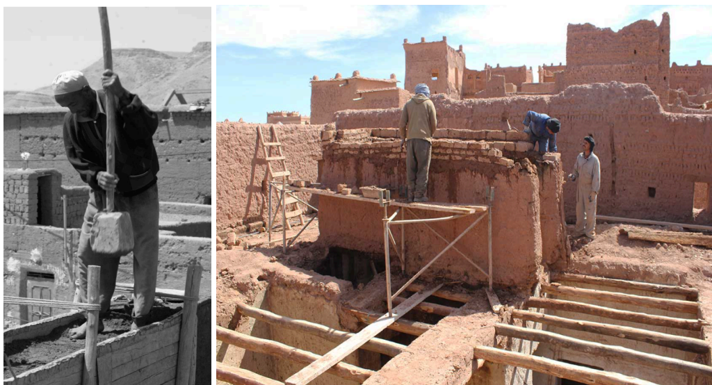
Figure 17 : Sur la photographie de gauche, le maleen tasse le pisé dans son coffrage. Sur celle de droite, les ouvriers préparent le niveau supérieur du mur. Photographies de Mohammed Barjali, 2004.
