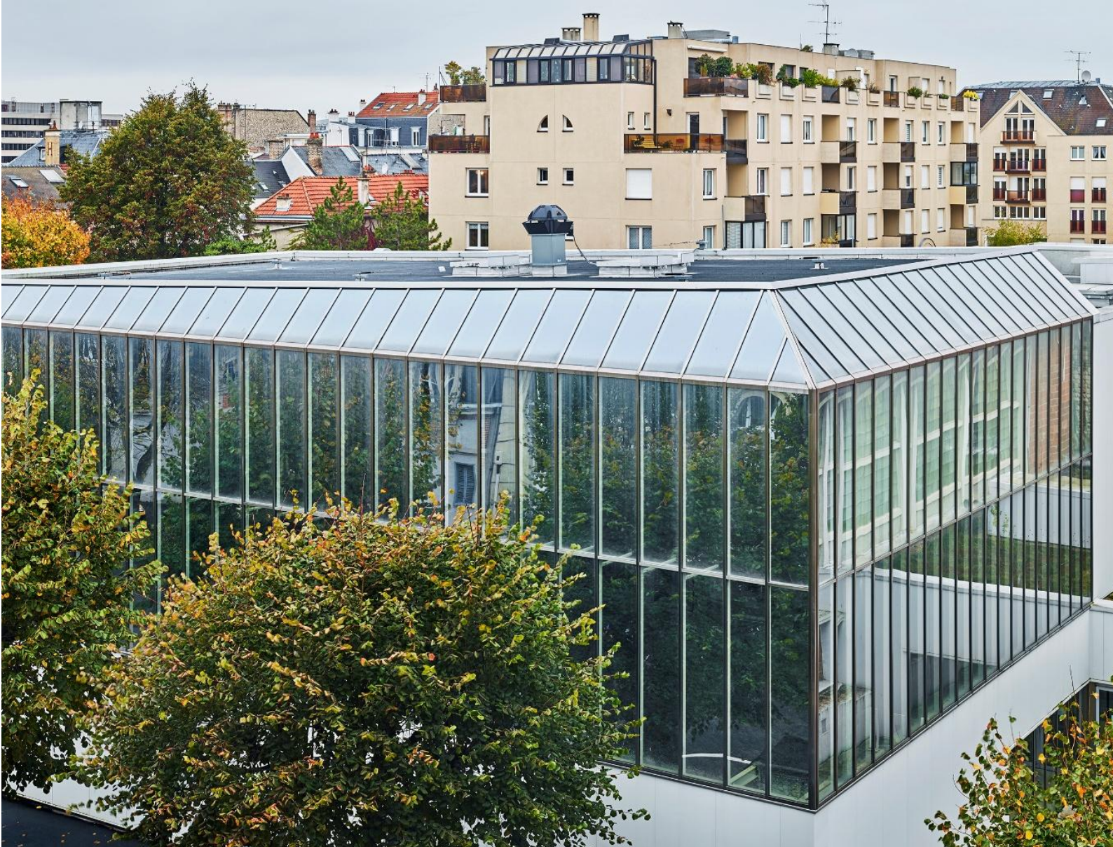
Figure 38 : photographie du mur trombe en façade de l'extension avec des verrières équipées de capteurs thermiques en partie supérieure _forster
