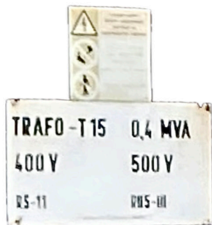
(Ostrava Vitkovice, risques d'électrification)
