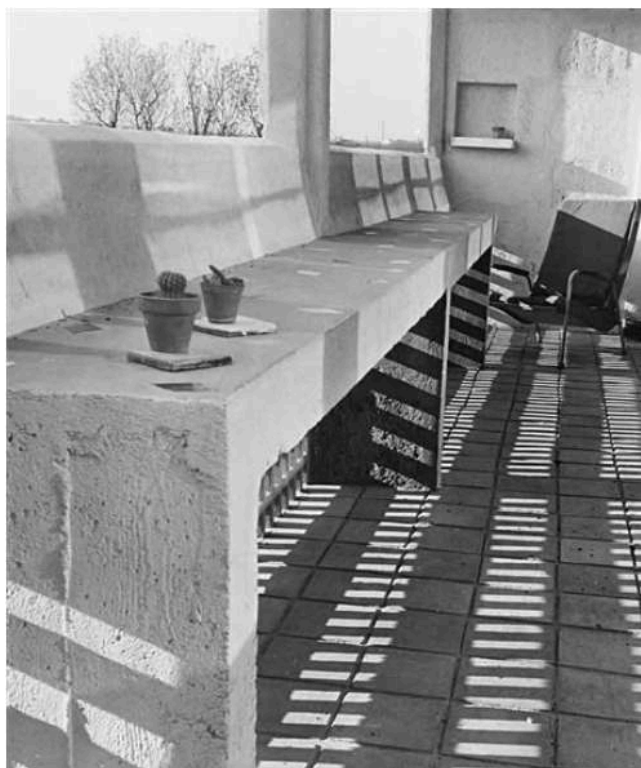
12: Photographie du balcon de l'Unité d'Habitation de Marseille (voir Livret II, p. 4).
