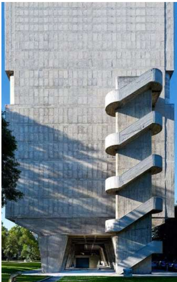
16: Photographie de la façade et escalier extérieur de l'Unité d'habitation à Marseille (voir Livret II, p. 4).
