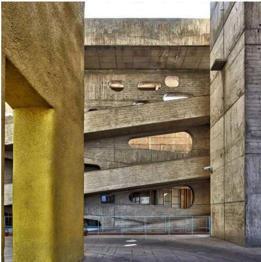
10: Photographie de la rampe du Tribunal Supérieur de la Justice Chandigarh en Inde (voir Livret II, p. 2).
