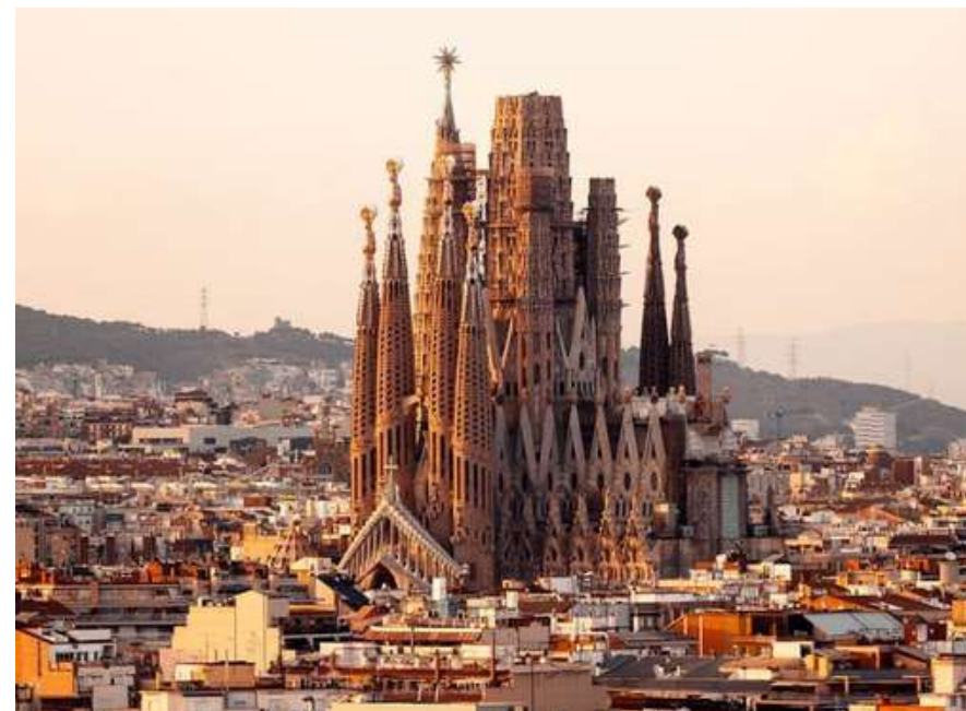
Fig 7 - Photographie de la façade sud - ouest
