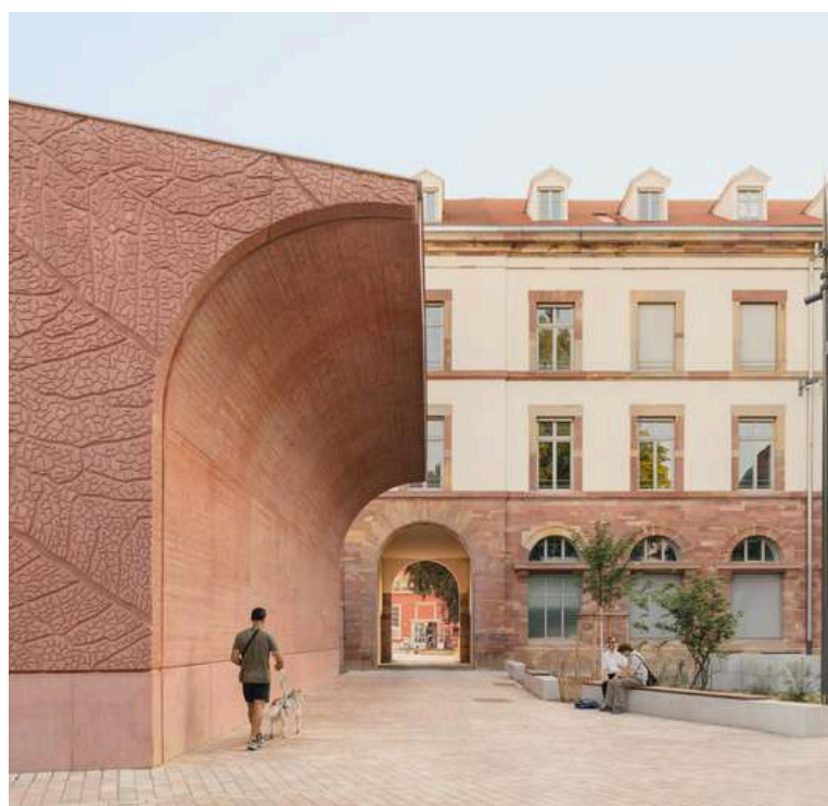
Fig 39 - Photographie de l'entrée Est
