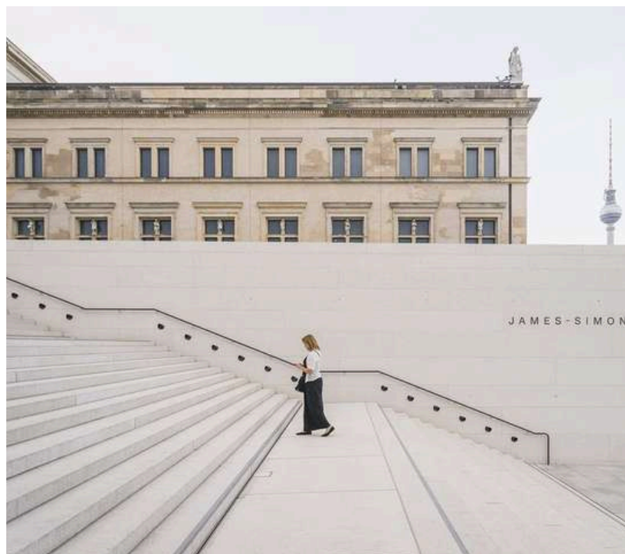
Fig 30 - Photographie de l'escalier d'entrée.
